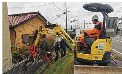
地震災害による危険ブロックの撤去
