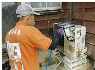
令和4年8月豪雨で室外機の消毒の様子
